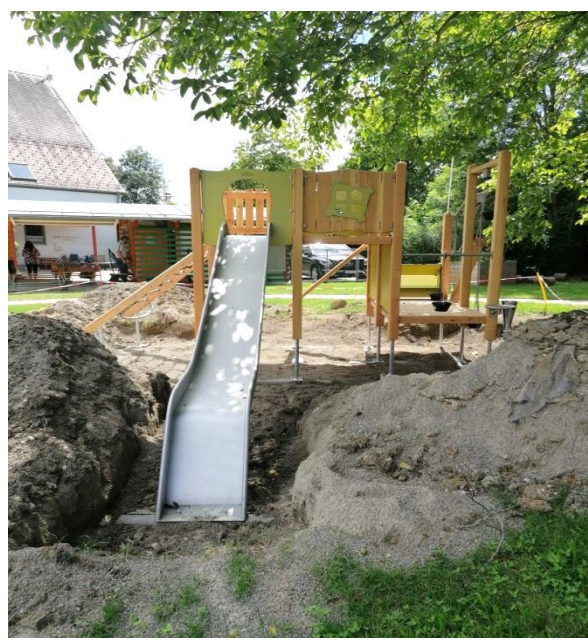
Baubilder vom neuen Gerüst. Bilder Kita Eisenburg
