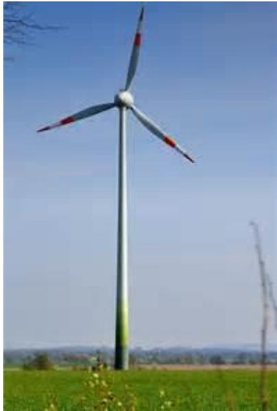
In Zusammenarbeit mit einem großen Deutschen Energieunternehmen wird im Rahmen eines Contractingmodells ein großes 135 m hohes Windrad am Hang vor der Kapelle, hinter dem RSV Heim aufgestellt, um hier die aufsteigenden Winde vom Volz-Gelände ausnutzen zu können. Die 3 Rotorblätter haben jeweils eine Länge von 105 m.
